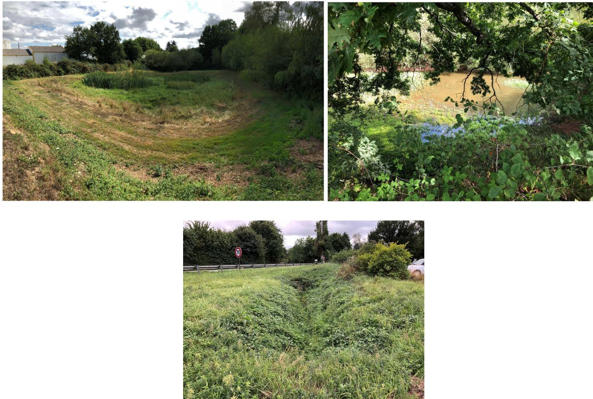
**Fig. 16 : l'ancienne carrière de la sablonnière (13 août 2019) faisant office de bassin d'infiltration des EP de la ZA de la Jaunaie mais aussi de la RD 47 (en bas)**
